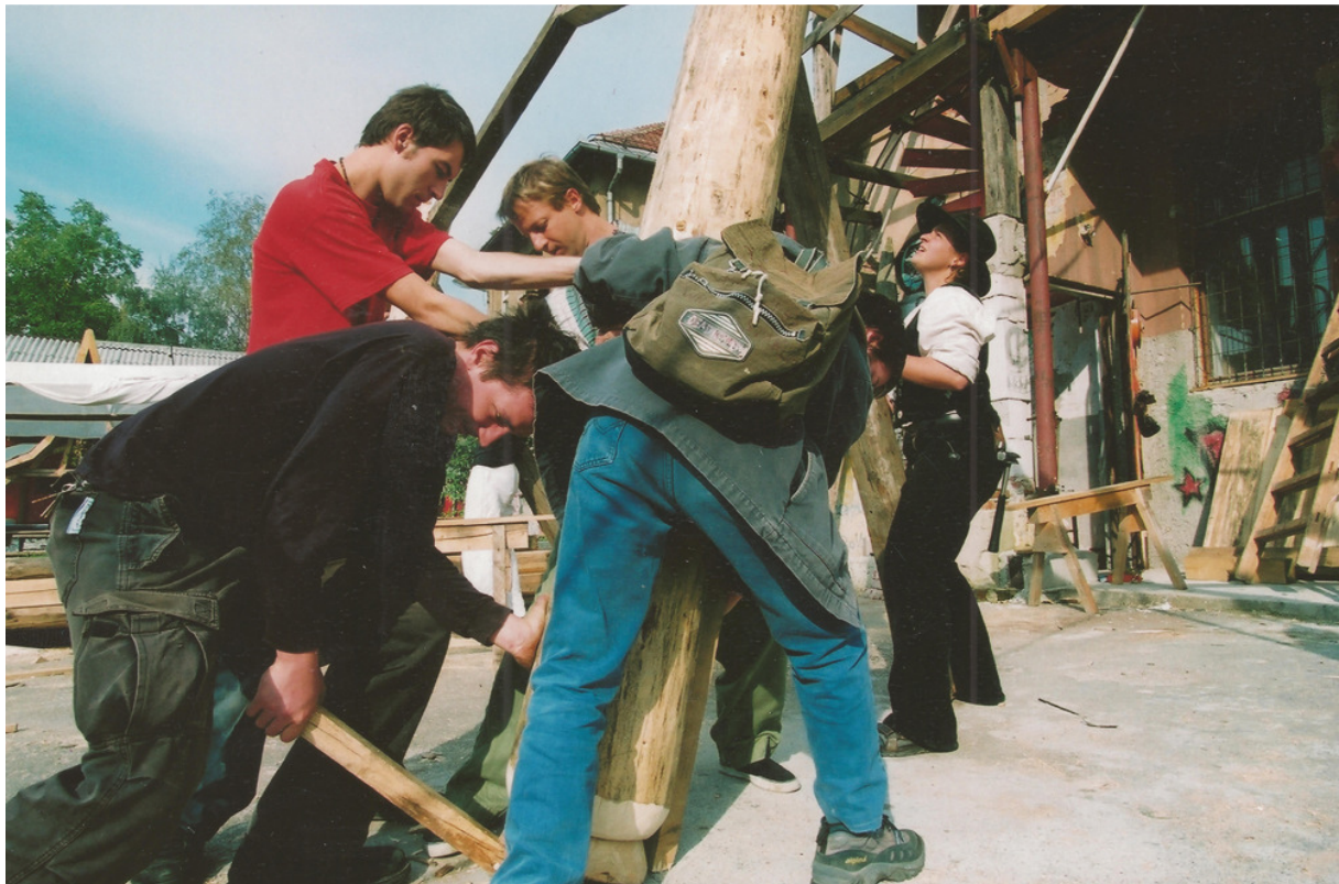
„Axt & Kelle“ rebuilds the Stables
